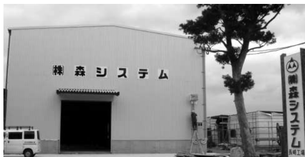
▲建設中の森システム長崎工場(田平)
