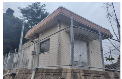
小手田中継ポンプ場
