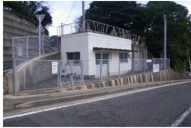
油水送水ポンプ場
