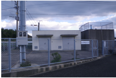
大久保中継ポンプ場
