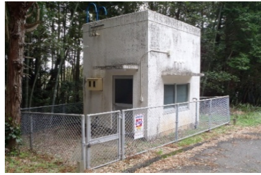
山中増圧ポンプ場
