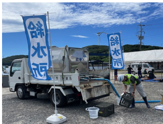
ステンレス製給水タンク
