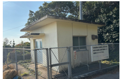
京崎送水ポンプ場
