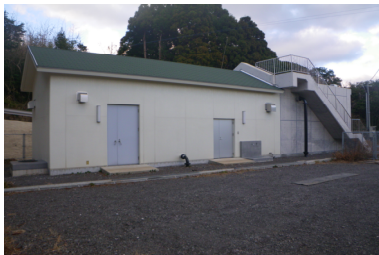
赤松中継ポンプ場
