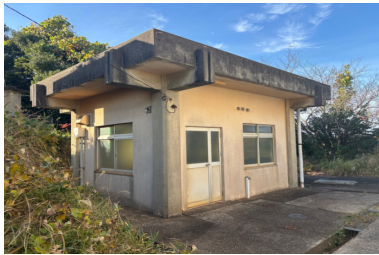
戸石川送水ポンプ場
