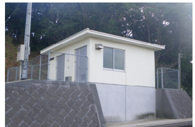
向月ポンプ場
