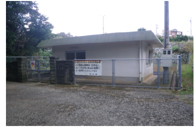
度島中継ポンプ場
