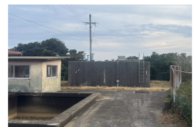
大根坂配水池
