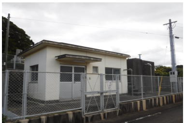
高越送水ポンプ場
