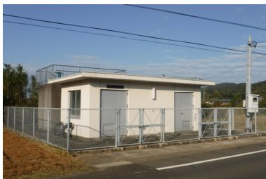
船越送水ポンプ場
