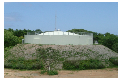
日ノ浦配水池
