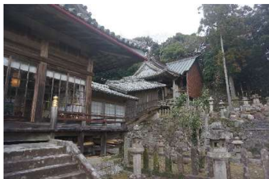
写真 64 亀岡神社本殿・登廊
