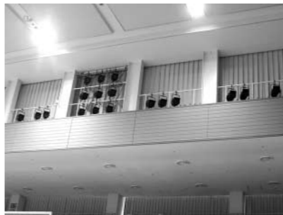
▲改修される照明施設
