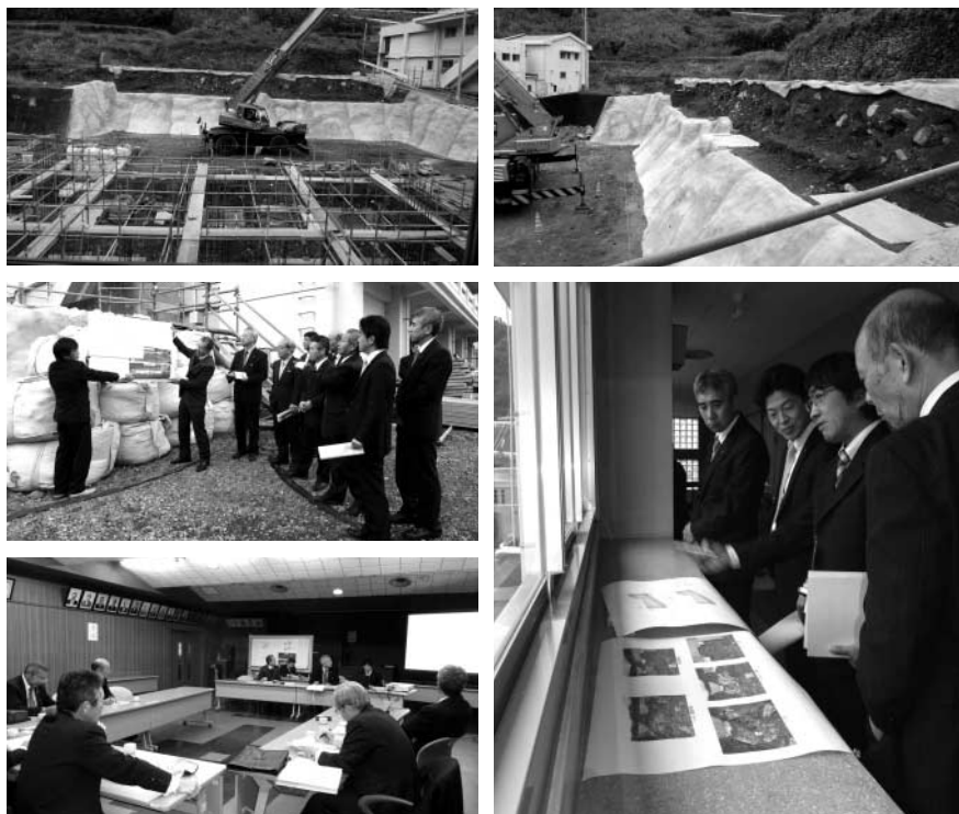
▲大島支所庁舎・公民館建設工事（建築工事）の現地踏査の様子
