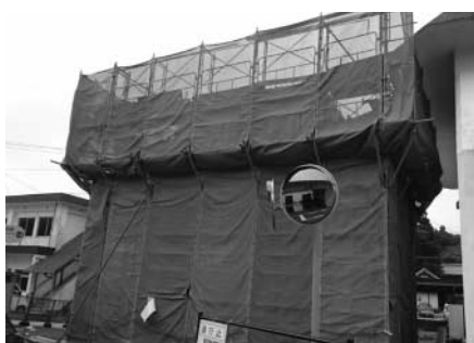
▲工事が進む山門の様子
