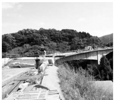
▲橋梁上部工事の様子(深川町)
