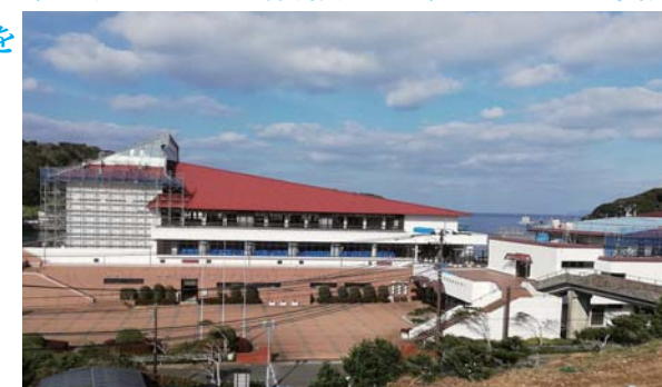
（改修中の平戸文化センター）
