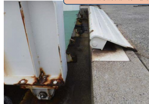
飯盛漁港 浮桟橋
