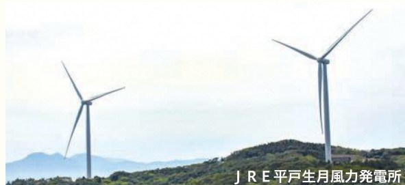
JRE平戸生月風力発電所
