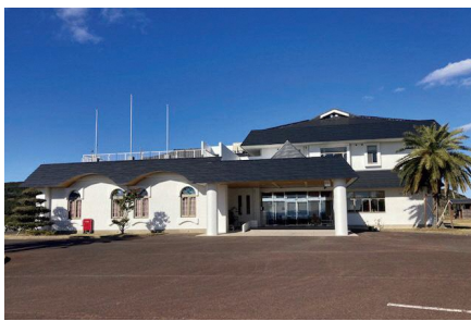
改装後の漁火館
