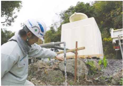
▲大瀬地区に仮設された貯水槽
