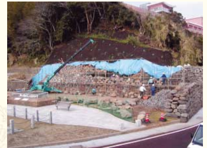
▲石垣の修復作業の様子
