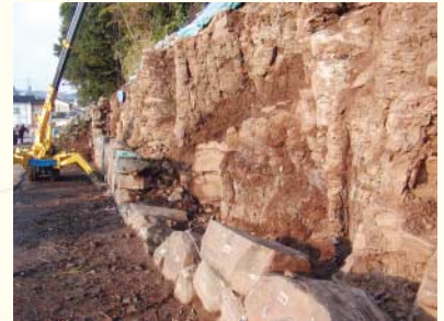
▲石垣の解体状況
