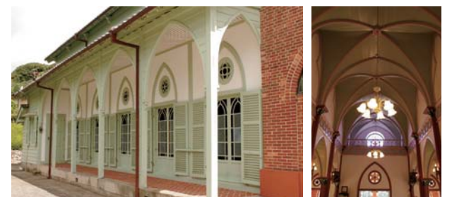
▲㉔会堂部の側面に設けられたテラス、㉕リブ・ヴォールト（こもり）天井など宝亀教会は特徴的な構造を持つ教会堂です。
