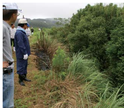
▲現場調査の釜田川周辺。清掃前の状態で、川面が見えないほど草が茂る
