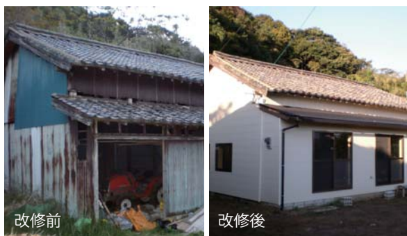
▲古い民家を大改修して地域の交流拠点施設とした「ヒラド・ビッグフューチャーズ」
