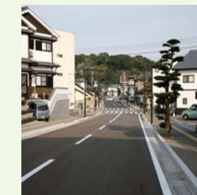
3月に完成した延長210m、幅員12mの亀岡上町線
