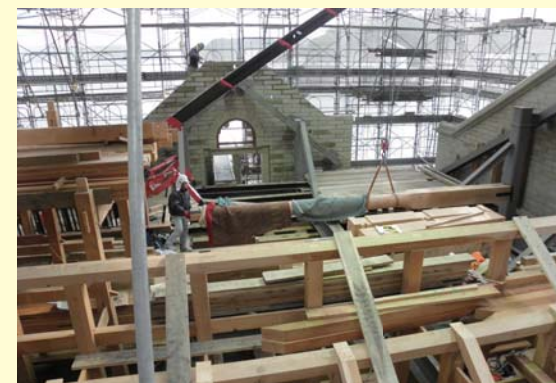
▲巻上げ機は、オランダ商館両端の破風に一基ずつ取り付けられます
