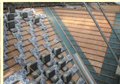
▲野地板を張る作業が完了。これから瓦を一つ一つ葺いていきます
