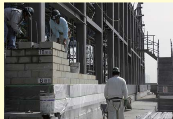
▲約2万個の壁石を積み上げ、その上に漆喰を塗る作業を行います
