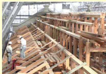
▲屋根裏の小屋組は、日本の建築様式が取り入れられています
