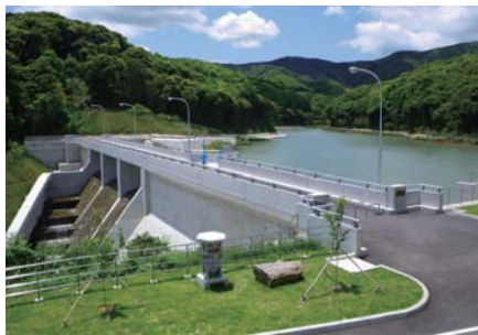
▲阿奈田ダム 周囲には、植栽されている桜やツツジの木などが、四季を感じさせてくれます。
