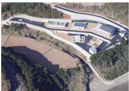
▲阿奈田浄水場 市内で一番新しく平成23年2月に完成した施設です。
