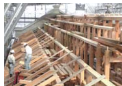
日本建築の技術を踏襲した屋根造り
