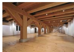
建物中央に立ち並ぶ柱
