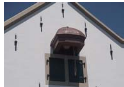
破風に取付けられた「巻上げ機」
