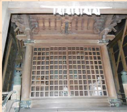
▲覆屋内部の霊殿(本殿)
