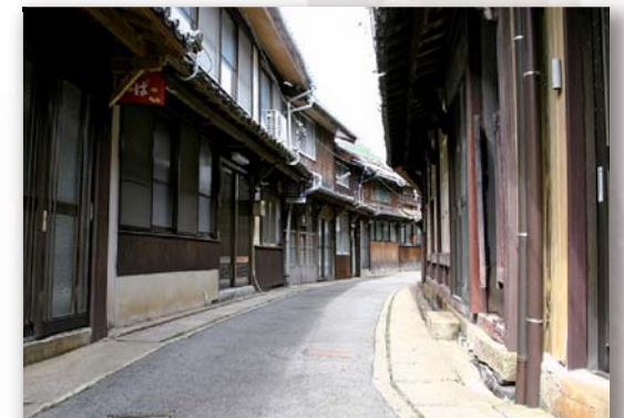
大島村神浦地区が国の重要伝統的建造物群保存地区に選定
