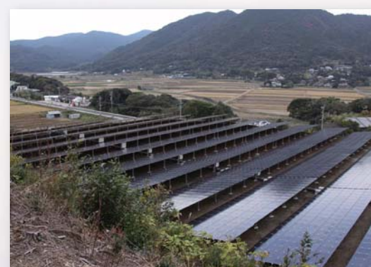
市下中野工業用地で大規模太陽光発電施設竣工式
