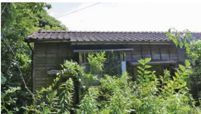
人が住まない空き家は、老朽化が激しく、草や木で覆われているものが多い。
