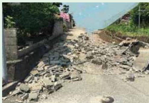
崩落したブロック塀
