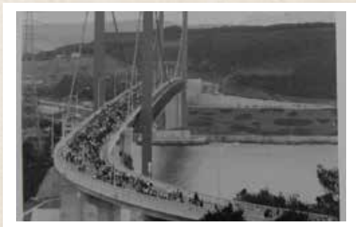
平戸大橋の開通式の様子
