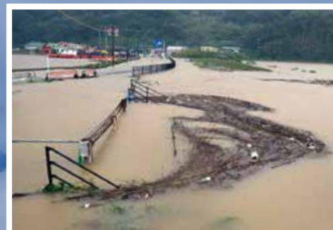
令和元年8月26～29日 前線による大雨
