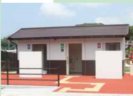
多目的トイレ
