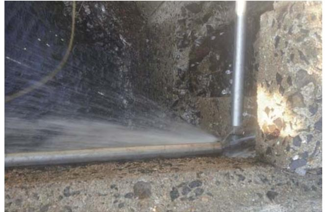
昨年は、このような水道管破損による漏水事故が、市内各地(約1,300世帯)で発生しました。
