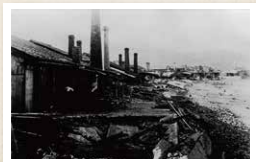
潮見地区の製造納屋群 (昭和26年)
