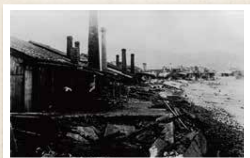
潮見地区の製造納屋群（昭和26年）
