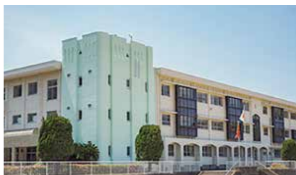
南部中学校校舎大規模改修事業 3億4,898万円 生徒の安全安心な教育環境の改善を図るため、屋上防水や内装の大規模改修を行いました。
