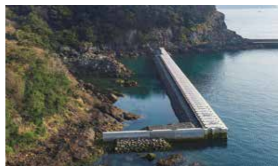
水産生産基盤整備事業 3億4,353万円 地域水産業の拠点を担う新獅子漁港(獅子地区)の防波堤、岸壁などの整備を行いました。
