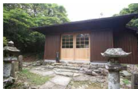
▲山頂付近に建てられた休憩所
