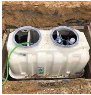
設置中の合併処理浄化槽▼
