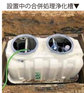
その中でも、平戸市では合併処理浄化槽（トイレ・台所など家庭内の汚水を併せて処理するもの）の設置を促進しています。
