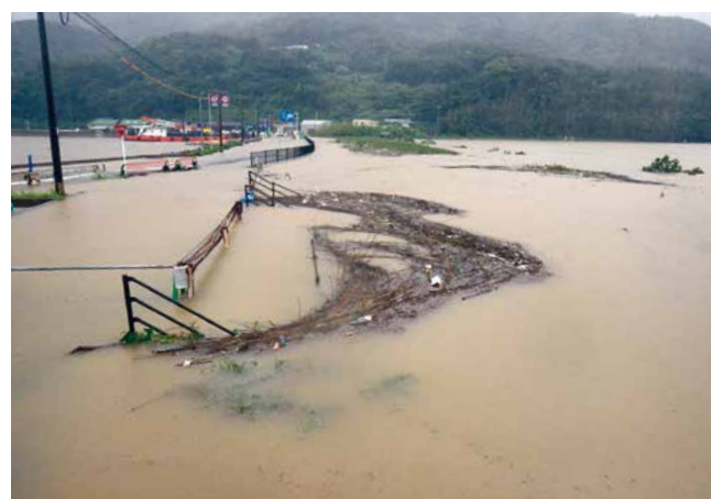
▲令和元年8月の豪雨災害(川内町)
