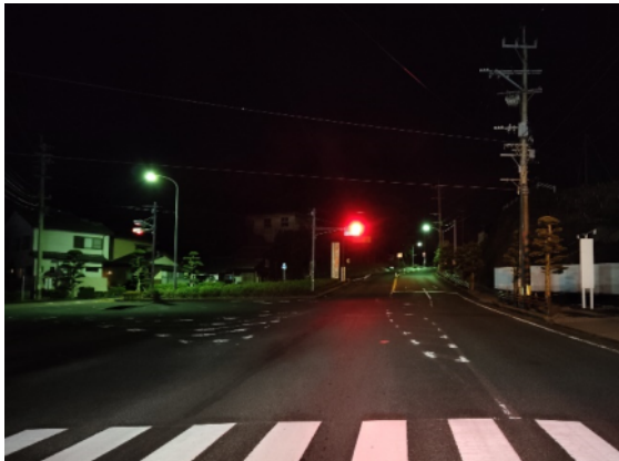
国道 383 号（大手の坂前交差点）
