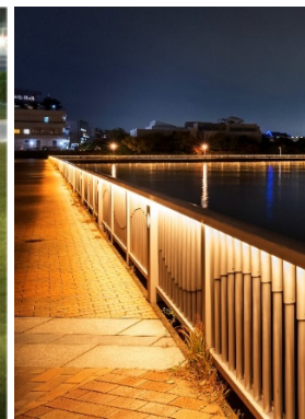
手すり間接照明
