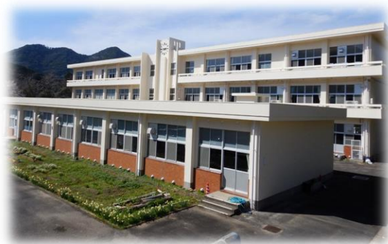
中野小（外壁改修後）
