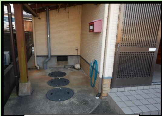
玄関横:浄化槽 設置
