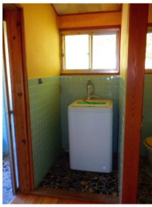
洗濯機置き場
