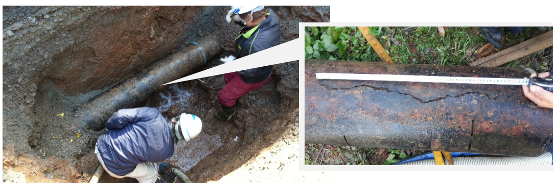
送水管（φ300）の破損状況
