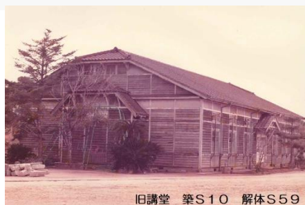
旧講堂 築S10 解体S59
